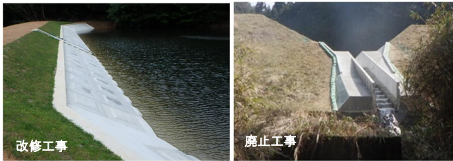
農業用ため池の防災工事
