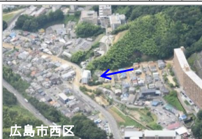
令和3年8月豪雨災害の被災状況
